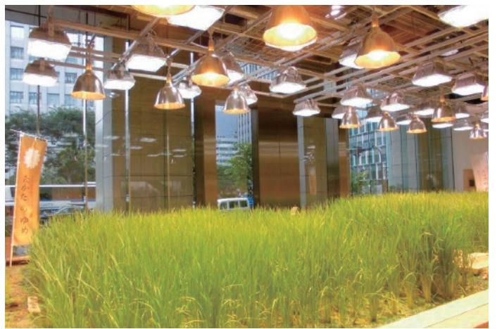
水田上部の光に注目。白い光はLED、オレンジ色は高圧ナトリウムランプ。この色は稲の生育に最も適した光です。
